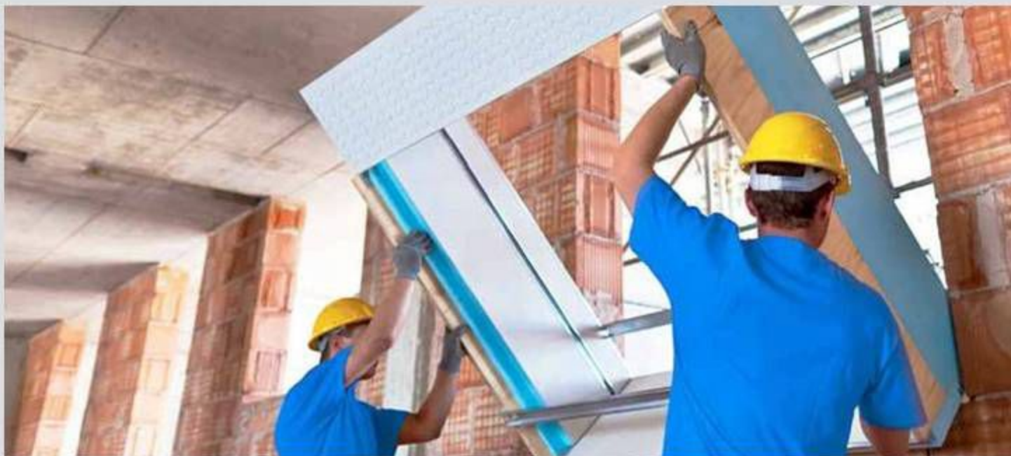
Pose du monobloc
